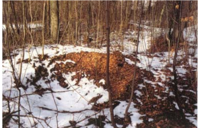
Tiertgartentunnel von Blankenheim. Trichter über einem der fünf Bauschächte des Tunnels.
