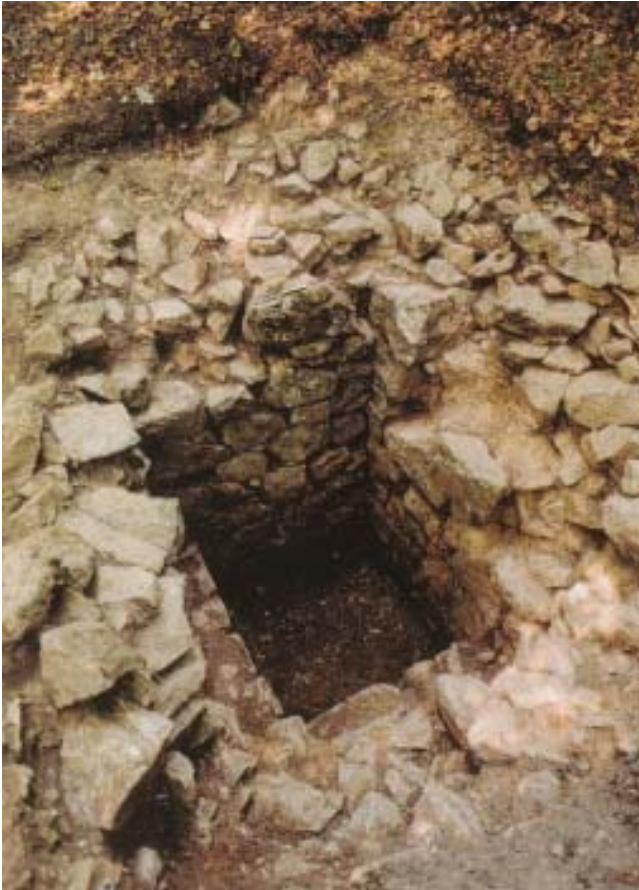
Abb.: Tiergartentunnel von Blankenheim. Freigelegte Ausmauerung des tiefsten Bauschachtes
